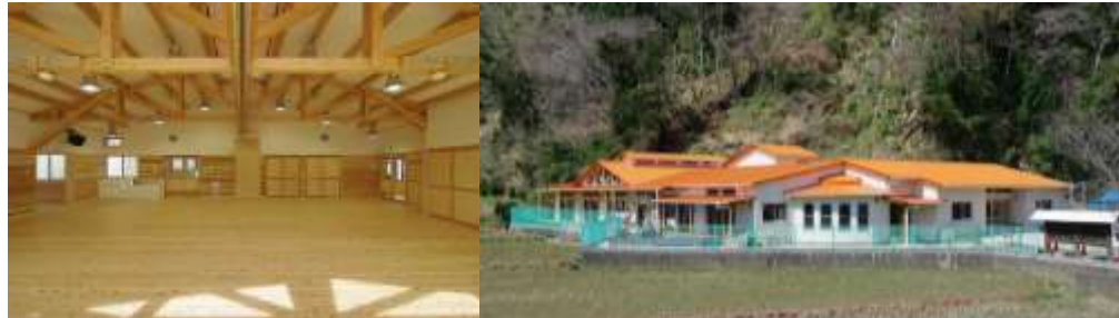
木造施設施工事例「風の子保育園」
