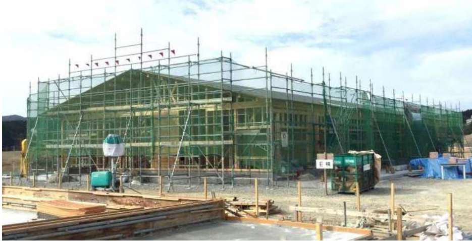
施工状況(10月24日)
