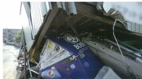
⑥接合部が破断し湾曲した鉄骨造の建築物
