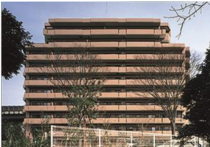
ナイスグループ初の免震マンション 「ナイスアーバン砦公園」 (39戸・1997年竣工・東京都世田谷区)
