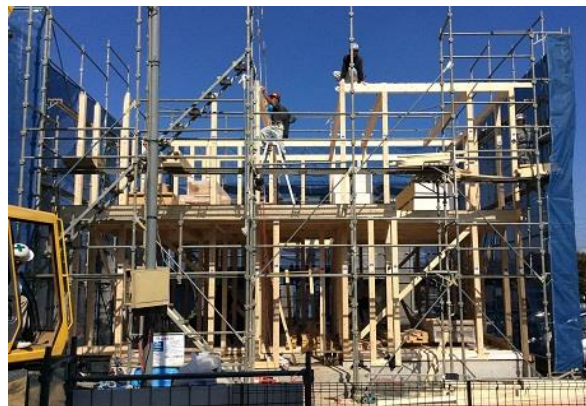
建築工事業（施工）
