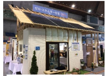
パッケージ化したゼロ・エネルギー住宅の実物大躯体を展示
