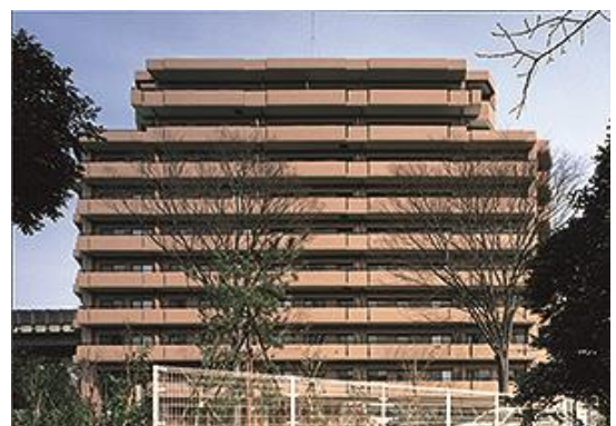
ナイスグループ初の免震マンション「ナイスアーバン砧公園」 (1997年竣工、東京都世田谷区)
