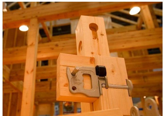
「パワービルド工法」を構造躯体に標準採用
