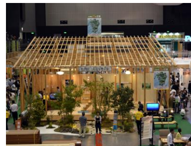
オール九州産材による実物大木造躯体
