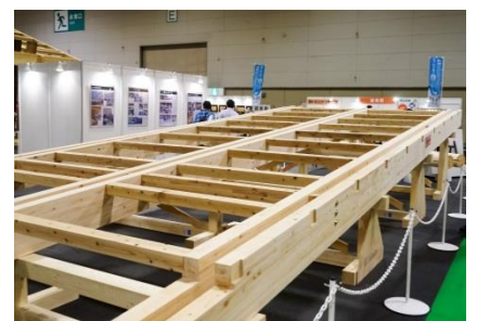
大開口を可能としたトラス梁構造の実物大躯体
