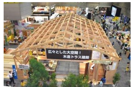
大開口を可能としたトラス梁構造の実物大躯体
