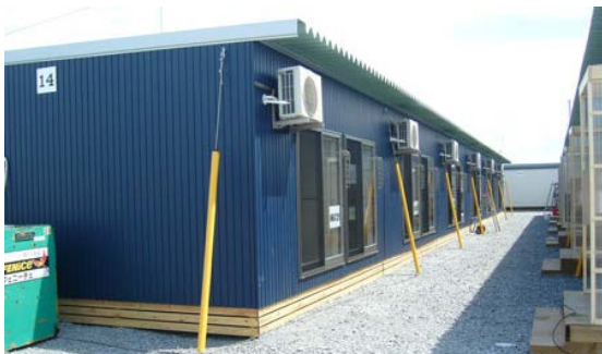
1,088戸の応急仮設住宅の建設に携わった (写真：宮城県東松島市)
