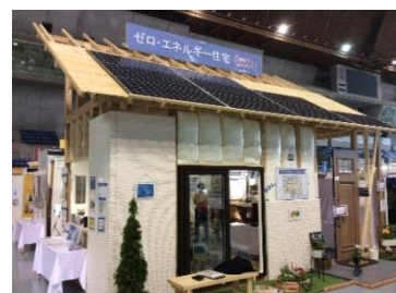
パッケージ化したゼロ・エネルギー住宅の実物大躯体を展示
