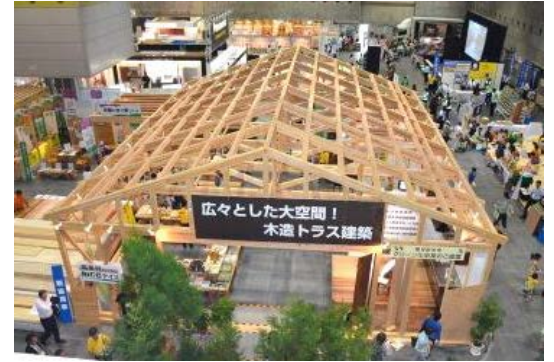
12mの間口を可能としたトラス梁構造の実物大躯体
