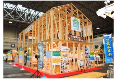
「木曽川流域のつながる家」構造躯体
