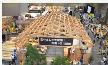
12mの間口を可能としたトラス構造の実物大躯体も展示
